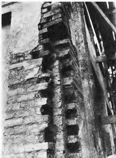
Bild 6. Detalj av överdelen av sydöstra hörnets pilastrar; mitt på fotot synas å pilastrarnas hitre kortsidor de kvarstående fragmenten av den undre kapitällisten.
