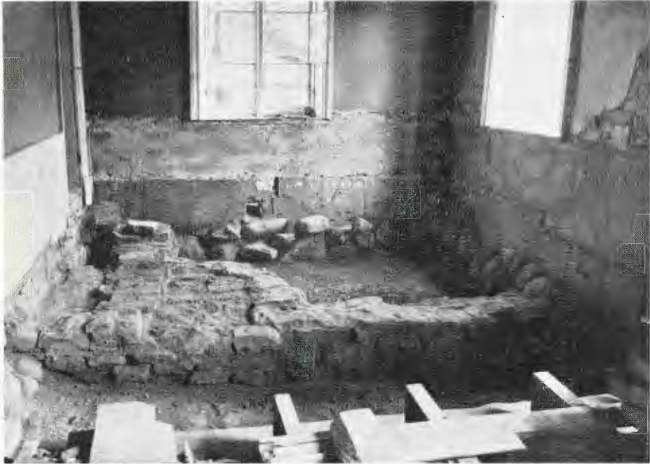
Bild 10. Från utgrävningen av Rudbeckshuset inom Linnéhusets sydöstra del; foto från väster; hela grundmurverket till Rudbecks köskammare blottat; i hitre vänstra hörnet eldstaden.
