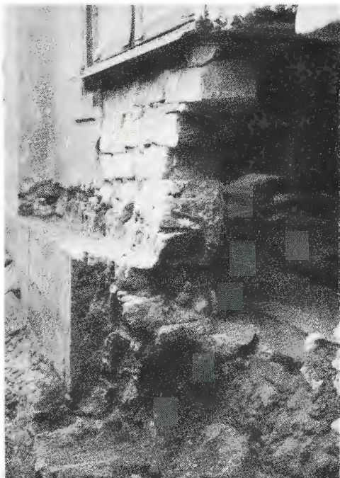
Bild 4. Snitt genom Rudbeckshusets endast en halv sten tjocka yttermur nära sydöstra hörnet.
