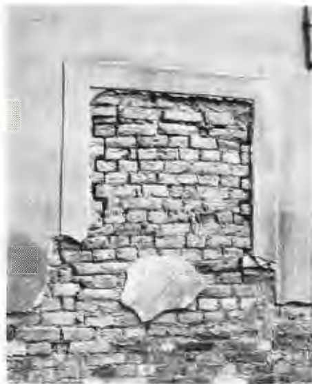
Bild 13. Blindfönstret å gårdsfasaden närmast Svartbäcksgatan. Stötfogarna till det Rudbeckska mindre fönstret synliga.
