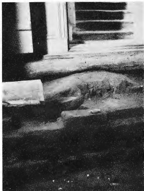
Bild 11. Tegelgrund till väggen mellan Rudbecks förstuga och ett hitre rum; där bakom synes valvhjässan till källarummet under Rudbeckshusets förstuga; foto från väster.
