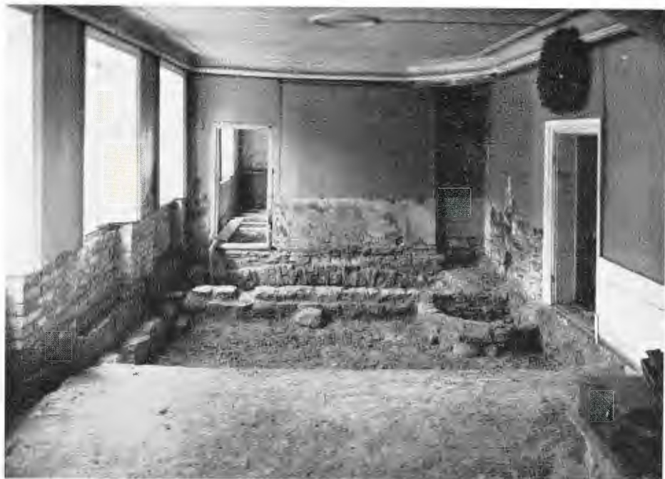
Bild 9. Från utgrävningen inne i Linnéhusets sal av resterna av Rudbeckshusets innerväggar; foto från öster; nedanför dörren t. h. synes grunden till den Rudbeckska salens eldstad; från dennas vänstra hörn utgår vinkelrätt mot fönsterväggen Rudbeckssalens västra vägg; i förgrunden valvhjässan till den mitt under denna sal belägna källaren; längst bort under Linnésalens vägg den vid 1740-talets ombyggnad anbragta bärande valvkonstruktionen.
