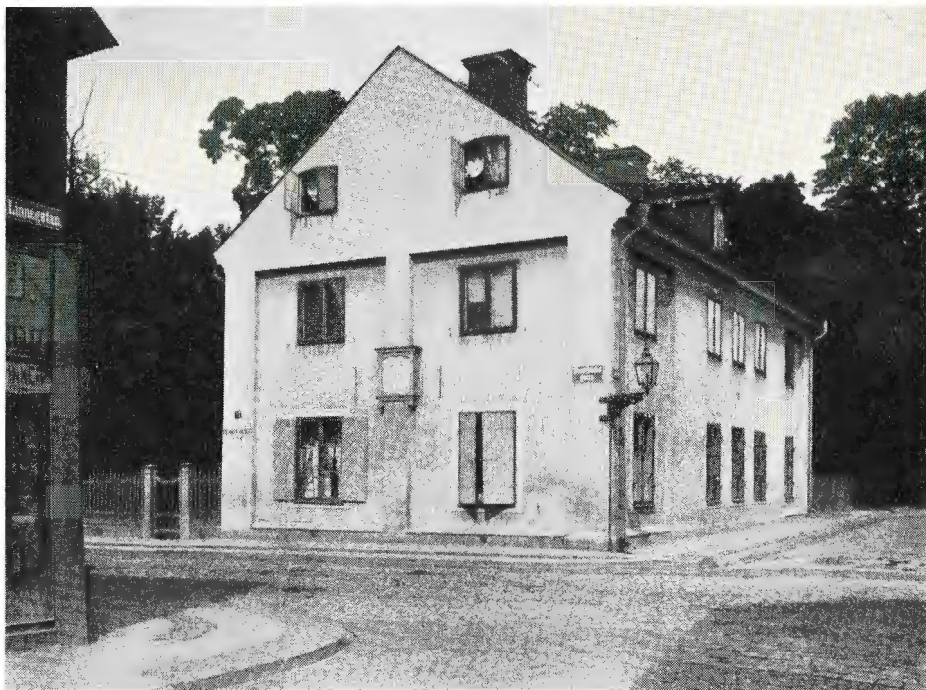
Bild 1. Prefekthuset vid Linnéträdgården, sett från sydväst. Fotot sannolikt från 1900-talets första år; fönsterluckorna å hitre gaveln äro de gamla från Linnés tid (1743—1778).
