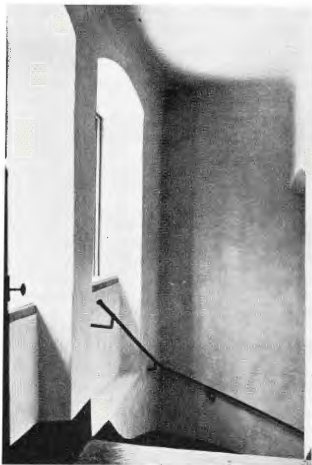
Fig. 36. Övre förstugan med blick ner mot trappan.
